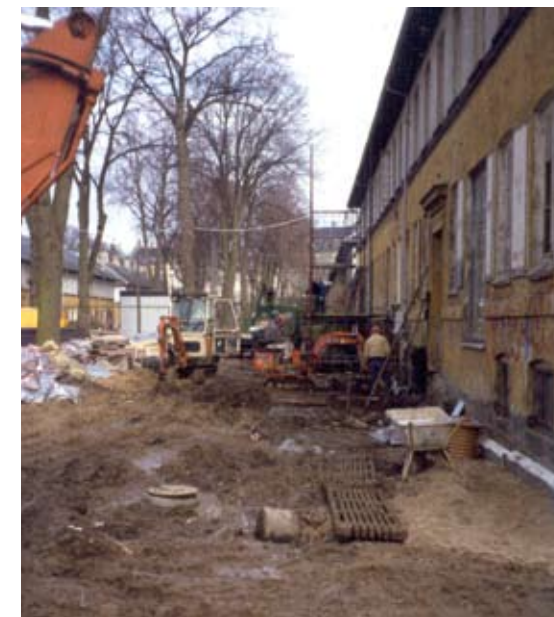
Den omhyggelige og meget vellykkede renovering af samtlige huse, blev foretaget i 1980'erne. Fotos: Lone van Deurs
