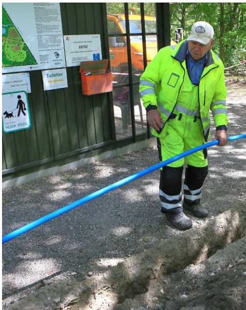
Svend Aage udfører vandforsyningsledning.
